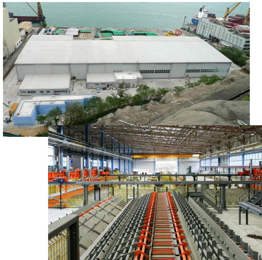
TVSC鋼鐵工場 (香港青衣)
